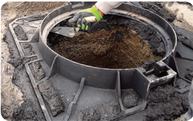
5 Utrditev na notranji strani s tiksotropnim BetonRoad.
