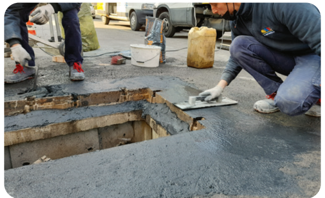
7 Zaključna obdelava z BetonRoad.
