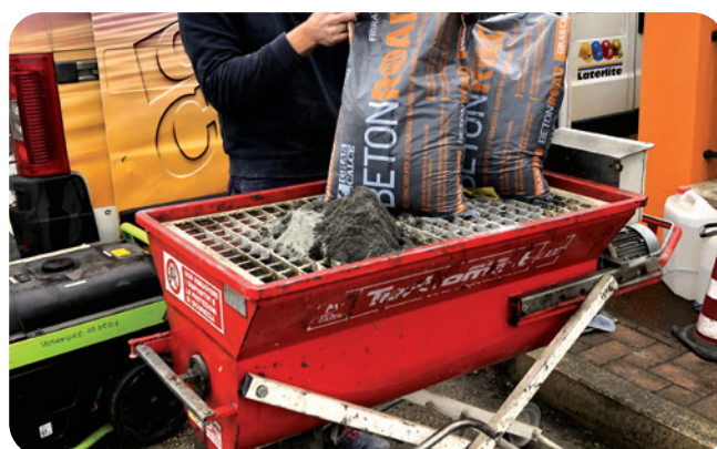
2A. Priprava BetonRoad z vijačnim mešalnikom.
