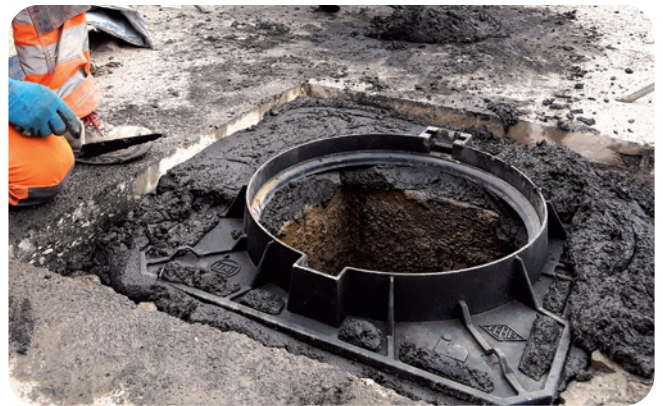
6a. Zapolnitev na zunanji strani s tiksotropnim BetonRoad.
